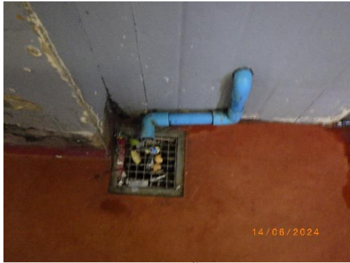
รูปที่ 24 ท่อรวบรวมน้ำห้องพักมูลฝอย
