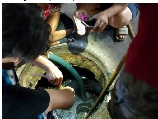
รูปที่ 9 การตัดไขมันจากถังตกไขมัน
