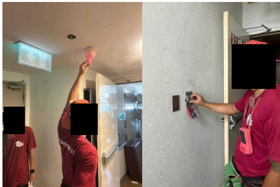
รูปที่ 31 การตรวจสอบระบบป้องกันและเตือนอัคคีภัย
