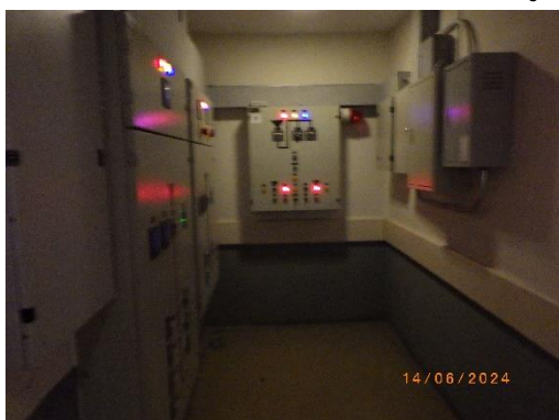
รูปที่ 7 ชุดควบคุมระบบบำบัดน้ำเสีย
