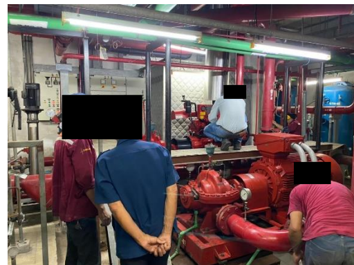
รูปที่ 48 การตรวจสอบ Fire Pump
